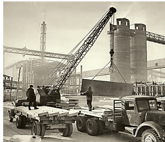
Строительство ИРКАЗа, 1950-ые
