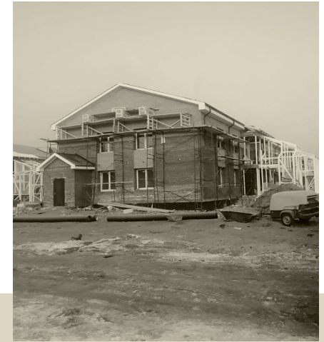
Строительство мкр. Угольщиков г. Тулун
