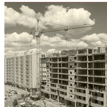
Жилищное строительство в Иркутске
